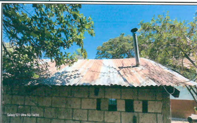
Foto 2: MEJORAMIENTO DE COCINA
