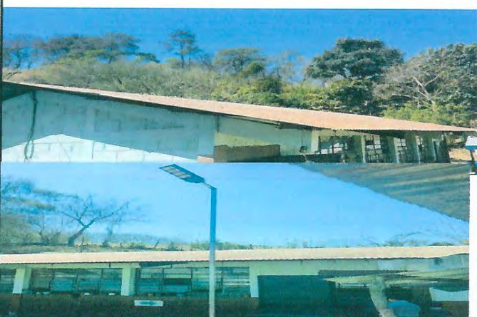
Foto 4: MEJORAMIENTO DE TRECHO DE AULAS
