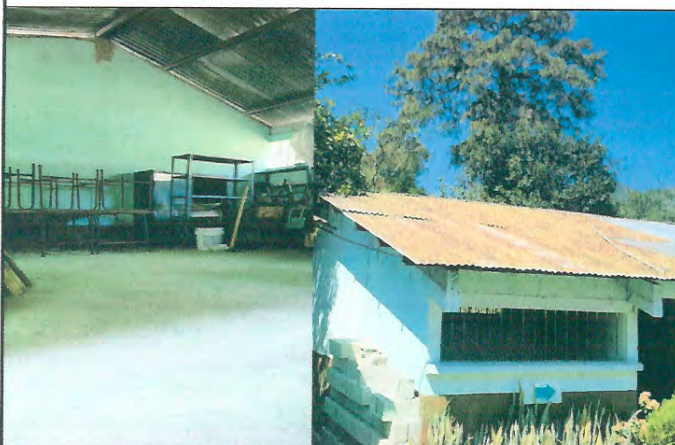
Foto 3: MEJORAMIENTO DE BODEGA
