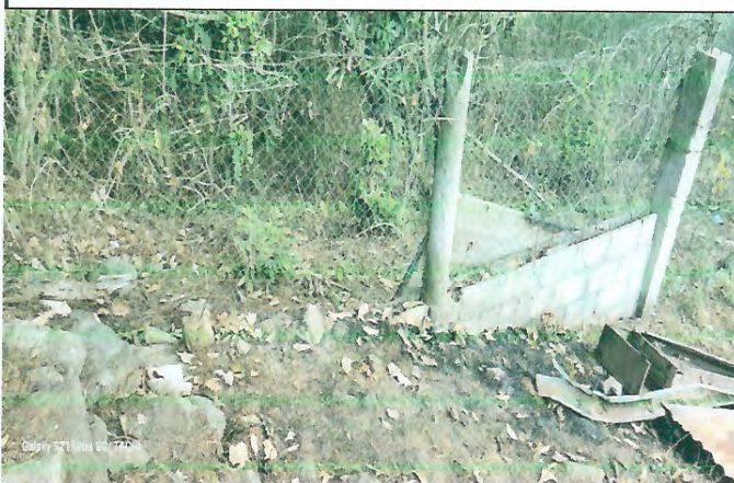
Foto 4: MEJORAMIENTO DE MURO PERIMETRAL
