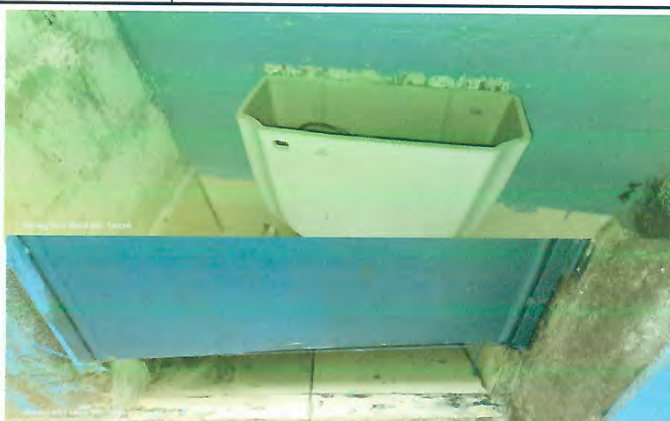
Foto 2: MEJORAMIENTO DE MODULO DE BAÑOS Y ACCESORIOS
