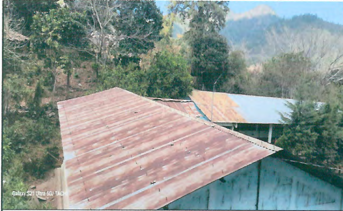
Foto 1: MEJORAMIENTO DE TECHO DE AULAS
