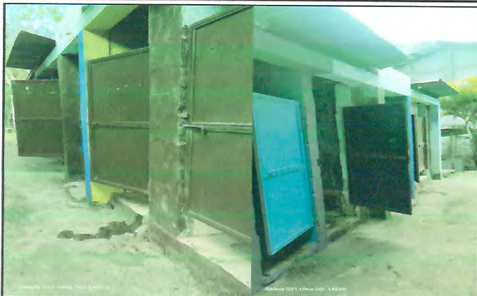
Foto 1: MEJORAMIENTO MODULO DE BAÑOS Y ACCESORIOS
