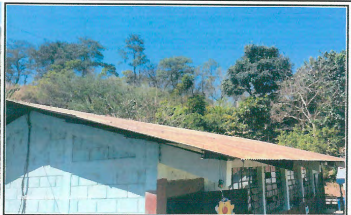
Foto 2: MEJORAMIENTO DE TECHO DE AULAS
