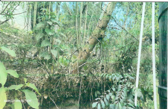
Foto 3: MEJORAMIENTO MURO PERIMETRAL
