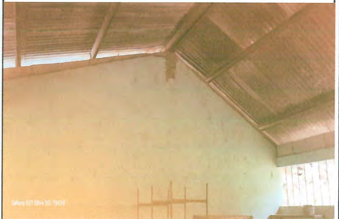
Foto 4: MEJORAMIENTO DE AULA, VENTANAL
